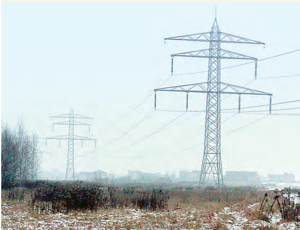
Fot. 9. Linia energetyczna w obrębie gruntów rolnych przeznaczonych do zalesienia (fot. W. Gil)
